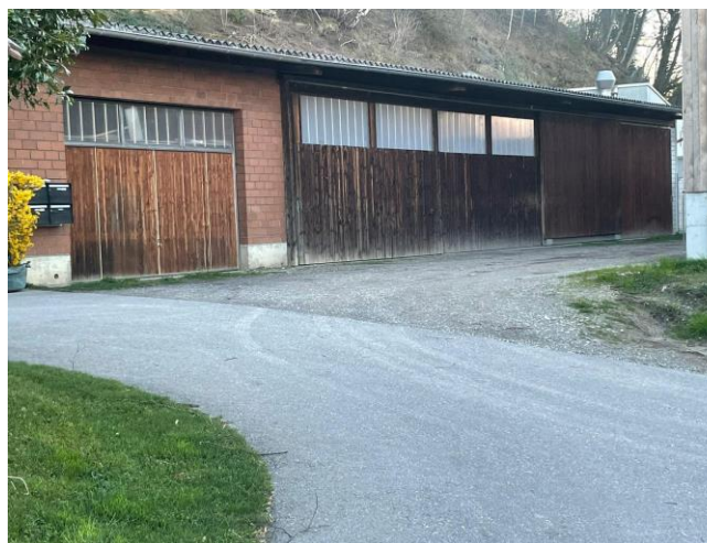
Maschinenhalle Nr. 56 E
