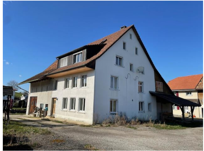
Wohn- Ökonomiegebäude (Südostansicht)
