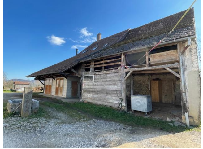
Wohn- Ökonomiegebäude (Nordansicht)
