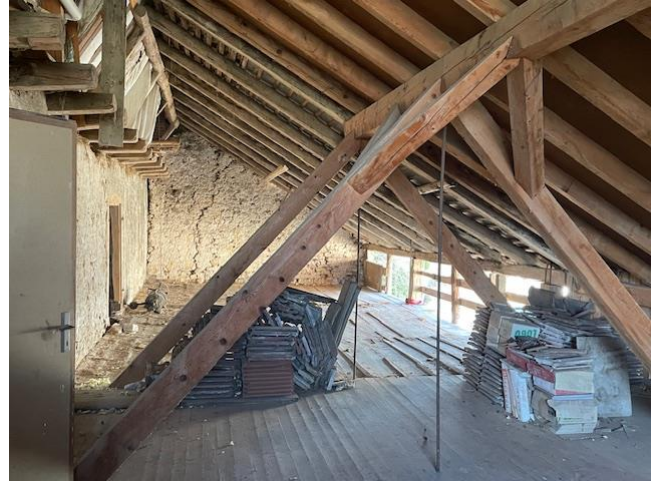
Ökonomieteil mit Zugang aus Wohnung 2 (1. OG)
