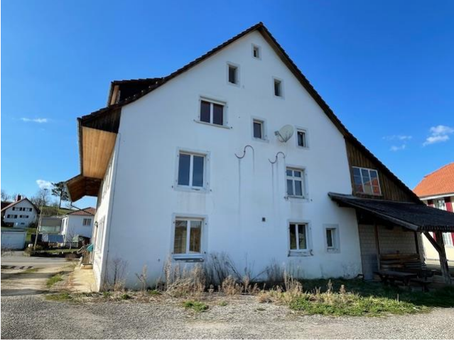
Wohn- Ökonomiegebäude (Ostfassade)
