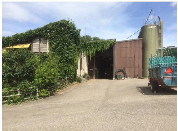
Remise und Hochsilos
