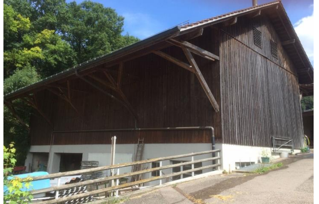
Remise mit Werkstatt
